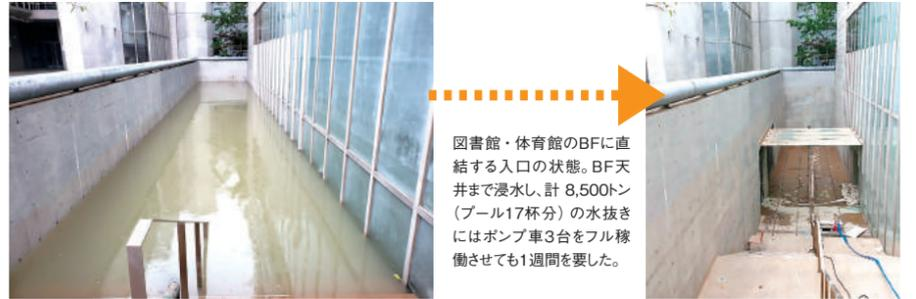
図書館・体育館のBFに直結する入口の状態。BF天井まで浸水し、計8,500トン(プール17杯分)の水抜きにはポンプ車3台をフル稼働させても1週間を要した。
