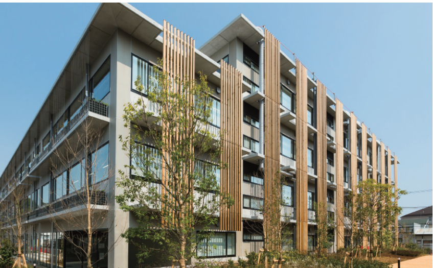
創発デザイン工学環が入る予定の6号館
